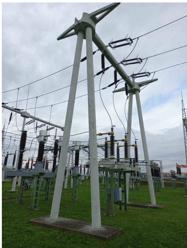
základové patky, betonové portály
